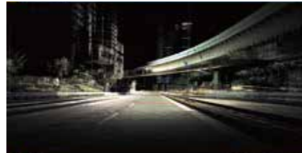
車両搭載型のレーザー計測システムで収集した高精度3次元座標点群
