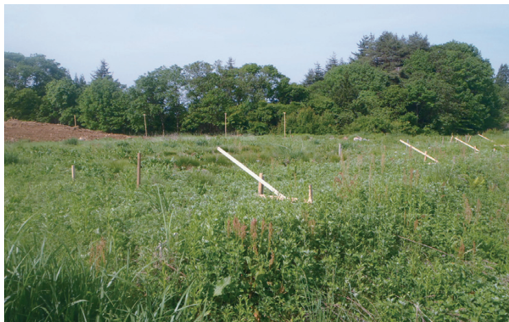
写真3 ■ 既存の樹木を伐採後に植生が再繁茂した箇所。このように草木で地形が隠れた箇所は、ドローン航測に不向き (写真:新井組)
