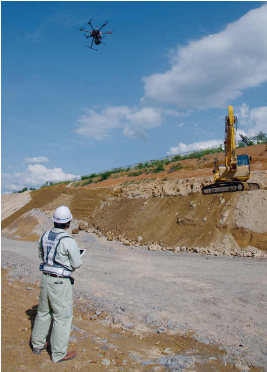
写真2 ■ 新井組と大山土木は15年度から、ドローン航測による現場測量や土工量管理などを実施。撮影画像の点群データ化にはAgisoft(アジソフト)社製「PhotoScan」、三次元点群処理ソフトは福井コンピュータの「TREND-POINT」を使用
