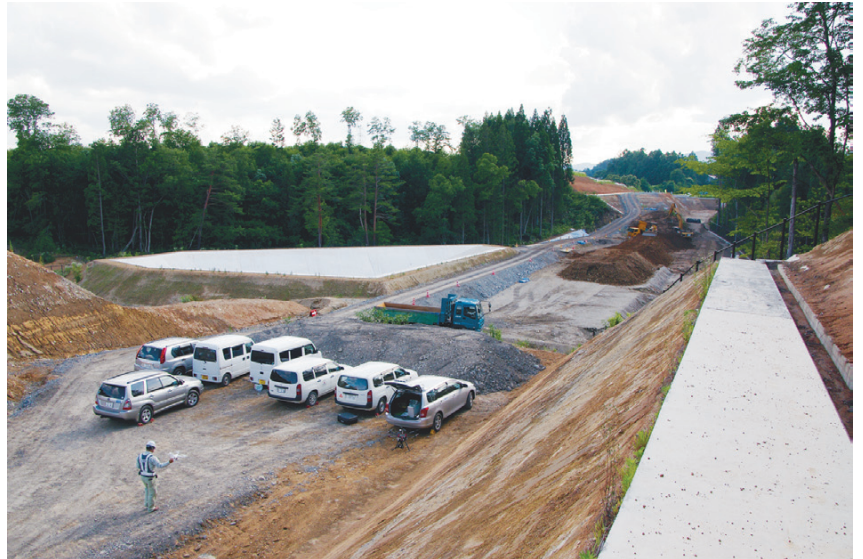
写真2 ■ 新井組と大山土木は15年度から、ドローン航測による現場測量や土工量管理などを実施。撮影画像の点群データ化にはAgisoft(アジソフト)社製「PhotoScan」、三次元点群処理ソフトは福井コンピュータの「TREND-POINT」を使用
