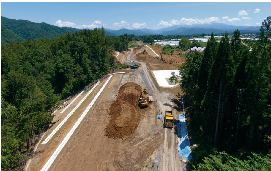
写真1 ■ 高山清見道路の現場。工事延長は合計約10km。200m前後ごとの工区分けで造成や高架構築が進む。中部地方整備局の見学推奨対象「旬な現場」の一つでもある。写真は7月初旬時点(写真:国土交通省高山国道事務所)
