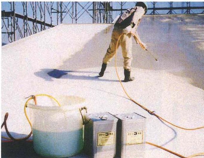
特許タケイ3号液 撒布浸透処理
