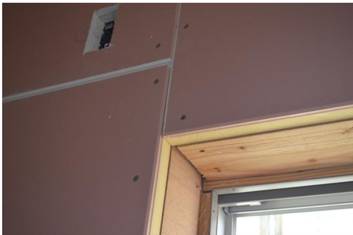
施工後の様子
