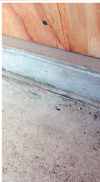
コンクリート打継部
