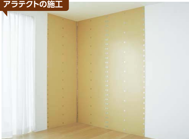
アラテクトの施工
