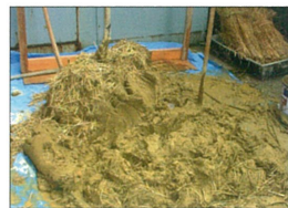
荒壁の施工には手間がかかりました。
