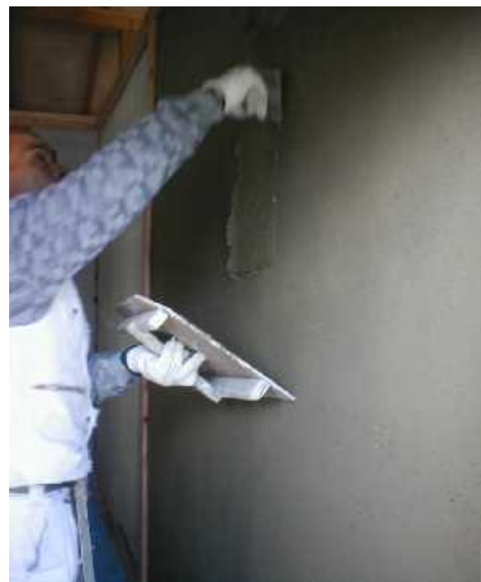
中塗り（乾燥後仕上げ塗り）
