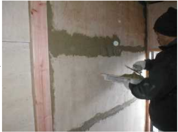
ジョイント部分をシゴキ塗り
