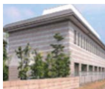
耐震構造ビル(IDC)
