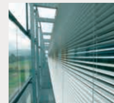
中間層で生じる高温の上昇気流にも、優れた耐久性を発揮
