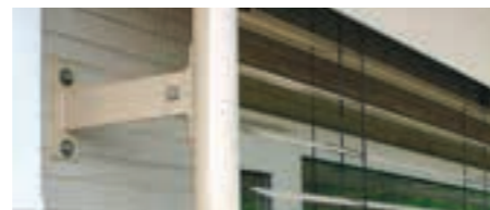
レールガイドを窓の両脇に固定
