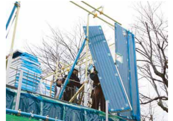
アルミ外装付き断熱打ち込み型枠 ガンバリボード
