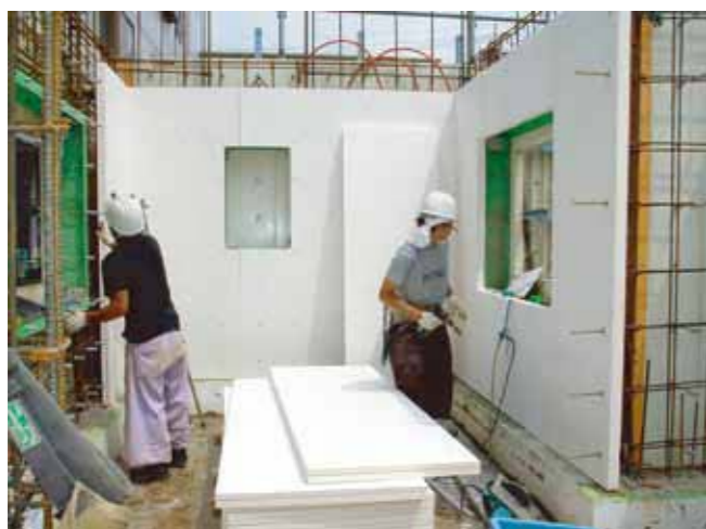
G内断熱工法での施工状況
