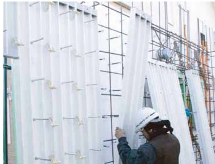
型枠職人でなくても、軽々と簡単に工事ができます
