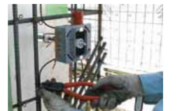
電気ボックスの施工状況
