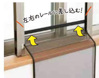
1 ネットセットを左右のレールに差し込みます。
