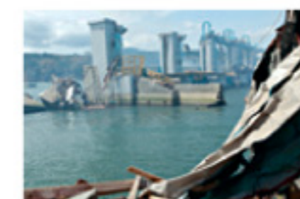
南三陸町志津川。防潮堤が崩壊し、水門は大破していた
