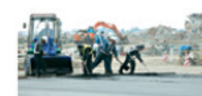
仙台市若林区荒浜。仮舗装して被災車両の仮置き場にする荒浜小学校
