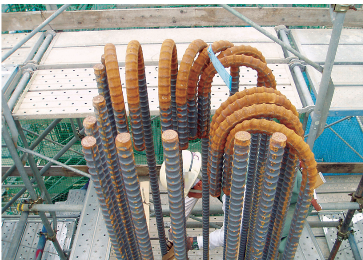
ある橋脚の柱の主鉄筋端部。この後に縦梁や横梁の鉄筋や補強鉄筋などを組む必要がある
