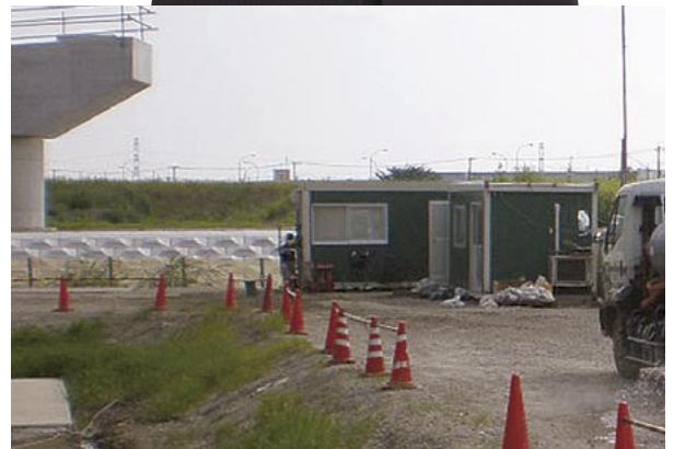
現場の敷地内に設置された二人用のプレハブ小屋。パソコンとプリンターを常備している (写真:大和小田急建設労働組合)
