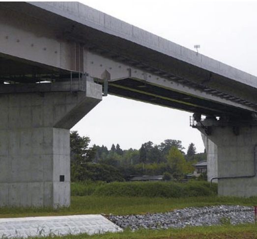
2006年9月末に完成した阿見高架橋。関東地方整備局初の設計・施工一括発注案件だった。技術提案の対象は、橋の上部工事と下部工事、仮設工事のそれぞれの設計と施工。橋の形式や構造などは自由に提案できる。ただし、鋼製の橋脚は提案できず、橋面舗装の施工は含まない。技術提案を求められなかった橋脚でミスが発生した
