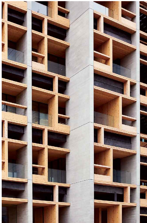
左：テラスの木を用いた部分は壁や手すりの位置を上下階で反転させ、変化のあるファサードにしている 上：北西から見る。左手前が新木場駅。北の壁面は、ヒノキと鉄のほか、スギの型枠を使って木目を写した打ち放しコンクリートで構成している
