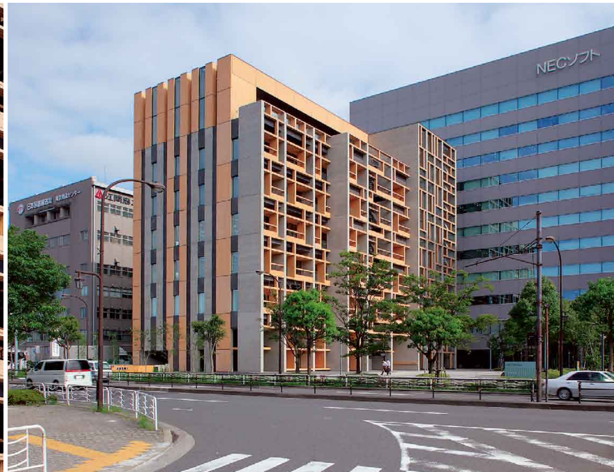
左：テラスの木を用いた部分は壁や手すりの位置を上下階で反転させ、変化のあるファサードにしている 上：北西から見る。左手前が新木場駅。北の壁面は、ヒノキと鉄のほか、スギの型枠を使って木目を写した打ち放しコンクリートで構成している
