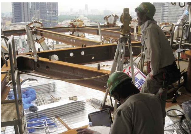
(左) 鉄骨の施工では、インナーコアを3層分先行して精度を確保していく中央コア先行型積層工法を採用した (右) だ円曲面を描く外周部のダイアゴナルの鉄骨の施工では、光波距離計とパソコンを利用した三次元計測システムを用いた
