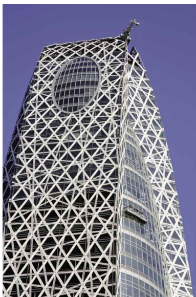
屋上からアームを延ばしてゴンドラを吊る
