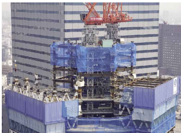
(左) 鉄骨の施工では、インナーコアを3層分先行して精度を確保していく中央コア先行型積層工法を採用した (右) だ円曲面を描く外周部のダイアゴナルの鉄骨の施工では、光波距離計とパソコンを利用した三次元計測システムを用いた
