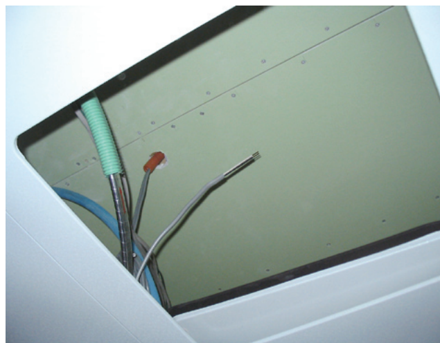
この写真のように、ユニットバスの周りにも、防火被覆が必要だ。ユニットバスを入れた後に防火被覆を施工しづらくなる壁は、外装材とあらかじめ一体化しておくといい
