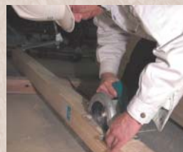
丸ノコで接着層に切り込みを入れ、はく離材の代わりとした
