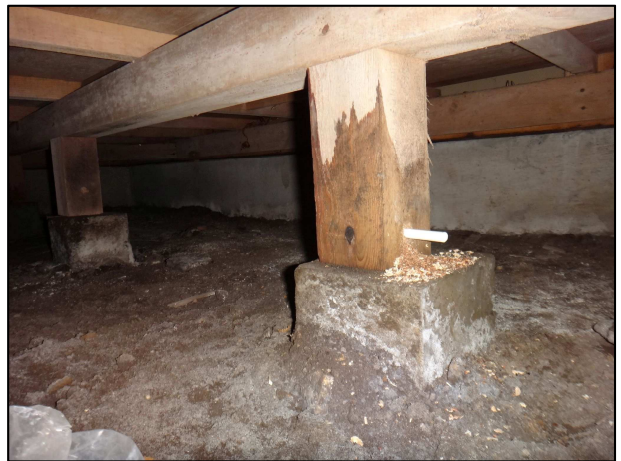
床下の束柱に。
