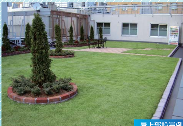
屋上部設置例
