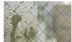
施工前 施工後
