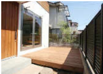
「屋外用」として塗装する例 原液2回塗り+ふきとりなし(栗材)
